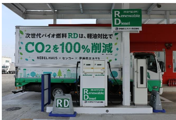
大阪南港店の RD 給油設備
